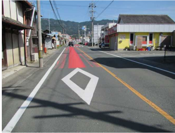
外側線、カラー塗装復旧
