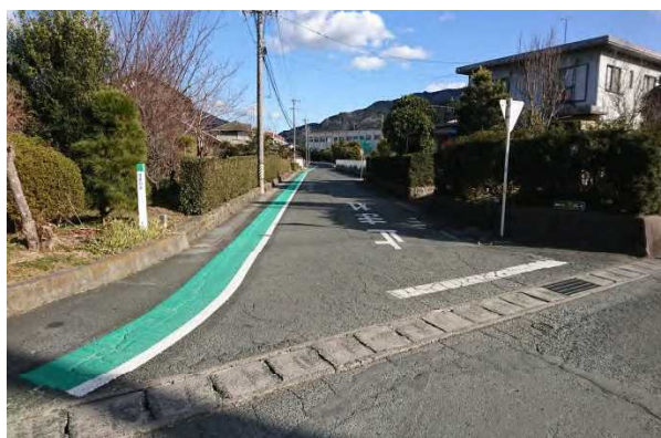
路肩カラー塗装設置
