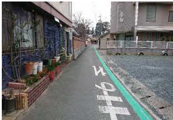
路肩カラー塗装設置
