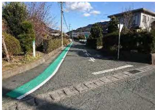
路肩カラー塗装設置
