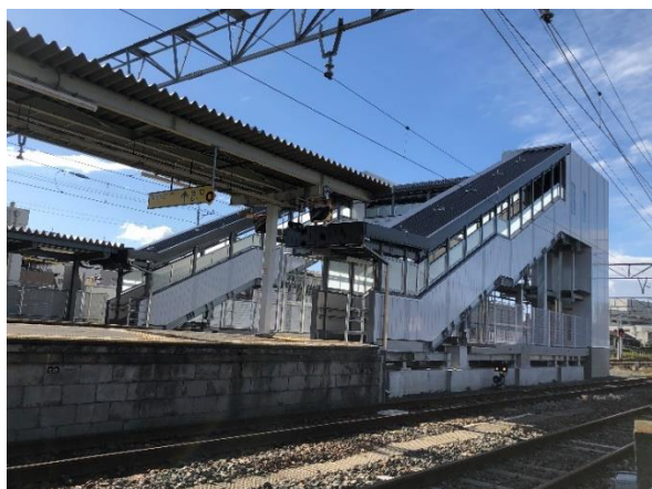
新城駅構内の整備状況
