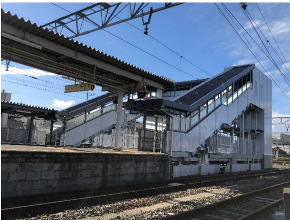
新城駅構内の整備状況
