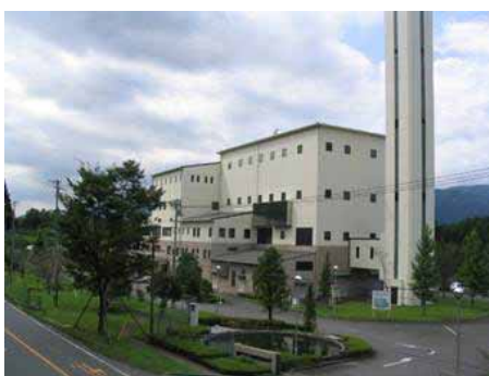
新城市クリーンセンター
