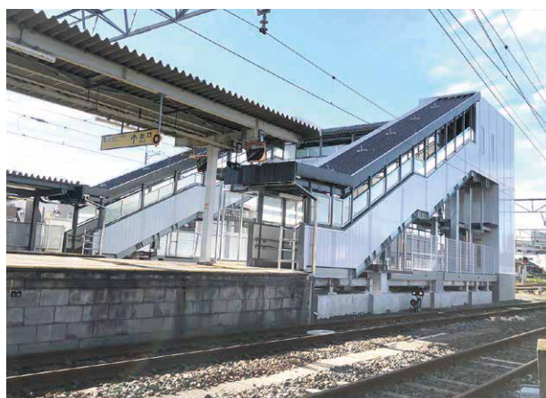
新城駅構内の整備状況
