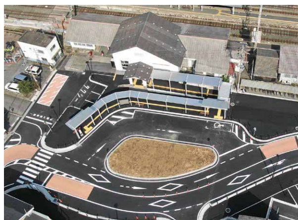
新城駅前広場の暫定整備
