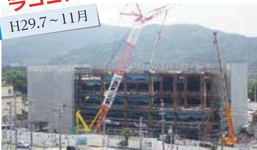
地上部鉄骨建方・躯体工事
