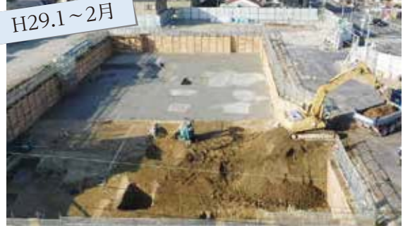
山留・土工事
