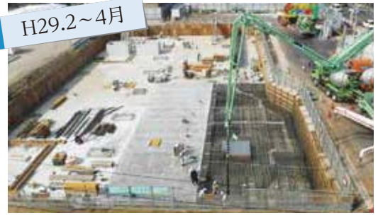
基礎躯体工事
