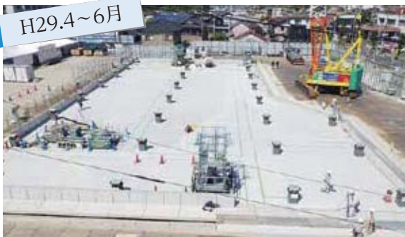
免震装置設置・1階躯体工事
