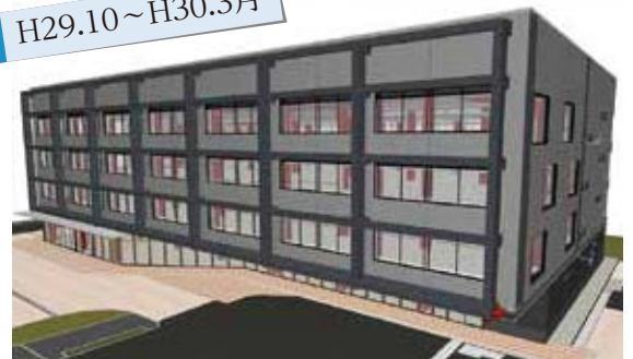
内装工事・外構工事（予定）
