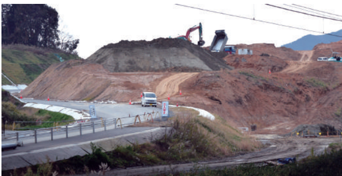
新城インター企業団地 (工事現場)
