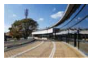
新城文化会館 昭和62年3月竣工
