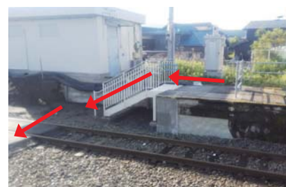
仮設通路設置中（駅構内） 遮断機などを設置し、 7月21日(火)から使用開始します。
